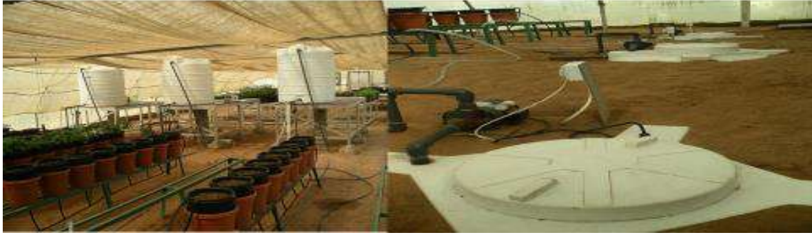
شكل 1 (أ): يبين الخزان المصنوع من الفبيرجلاس في نظام الري المغلق في الزراعة المائية والتي تم عمله في كلية الزراعة جامعة الإمارات العربية المتحدة. لاحظ وجود اجهزة ضبط درجة الاس الهيدروجيني في الصورة العلوية التي على اليمين. لاحظ وجود الخزانات العلوية في الشكل العلوي والسفلى ووجود الخزانات التي تحت الارض في الشكل السفلى على اليمين بحيث يكون نظام الزراعة المائية من النوع المغلق.
